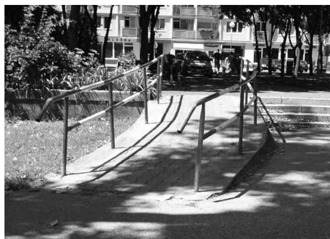
Zatáčanie prístupovej rampy môže spôsobiť ľuďom pohybujúcim sa na vozíku problémy, najmä v zime.
