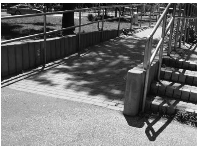
Vhodne riešená rampa pre ľudí pohybujúcich sa na invalidnom vozíku.
