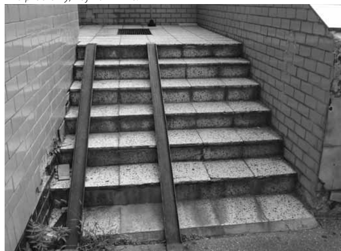
Nevhodne riešená, krátka a strmá prístupová rampa pre ľudí pohybujúcich sa na invalidnom vozíku.
