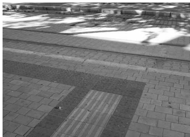
Bezbariérový prístup na zastávke električky v Bratislave, označený osobitnými pruhmi, aj s vyvýšenou nástupnou plochou.
